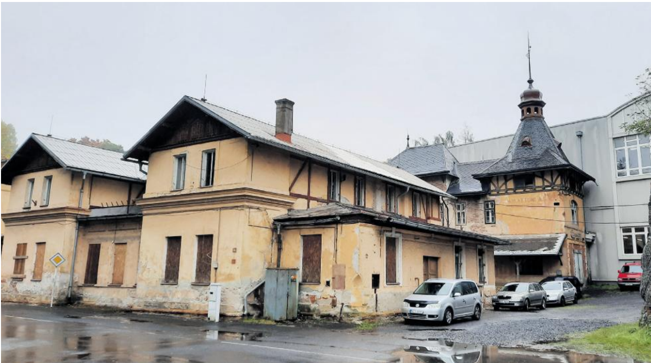
Bilder vom teilrenovierten Betriebsgelände in Gießhübl/Kyselka.
