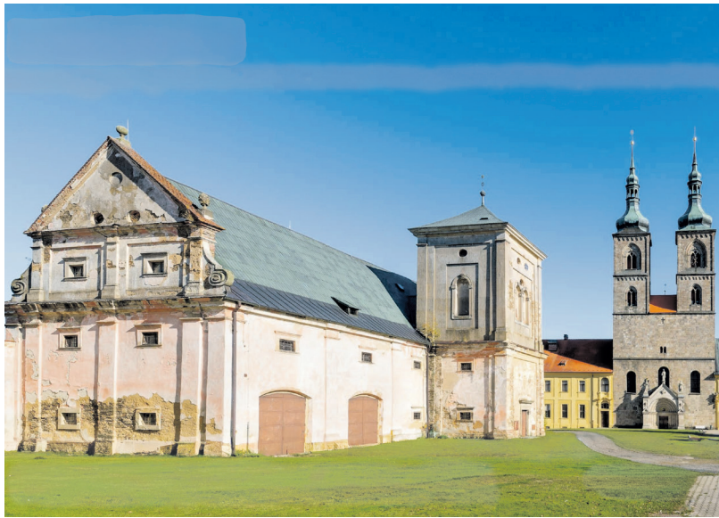
Die Wirtschaftsgebäude von Kloster Tepl sind verfallene „Lost Places“.
