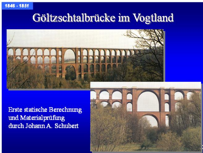
Im deutschen Sprachraum ist eine der ersten statischen Berechnungen im heutigen Sinne, bei der man Tragwerk und Konstruktion im Voraus analysierte, im Rahmen der Errichtung der *Göltzschtalbrücke* im Voigtland aufgestellt worden. Diese Brücke wurde in den Jahren 1846-1851 erbaut und ist die größte Ziegelbrücke der Welt (26 Millionen Ziegeln und 64 m<sup>3</sup> Naturstein). Berechnung und Materialprüfung erfolgten durch *Johann A. Schubert* aus Dresden.
