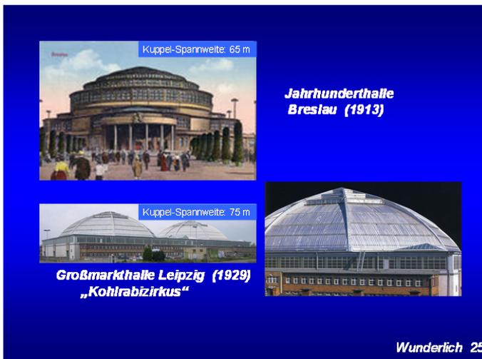
Diese Kuppel war mit einer freien Spannweite von 65 m Durchmesser zum Zeitpunkt der Fertigstellung weltweit die größte dieser Art und wurde ebenfalls von der Firma Dyckerhoff & Widmann gebaut, allerdings noch in aufgelöster Bauweise mit Rippen und Balken und noch nicht als reine Schale.
